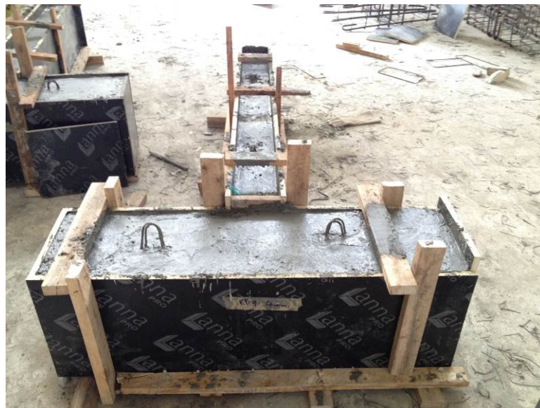
รูปที่ 2.11 การหล่อตัวอย่างทดสอบคานคอนกรีตที่มีรอยต่อแบบเพลทเหล็ก
