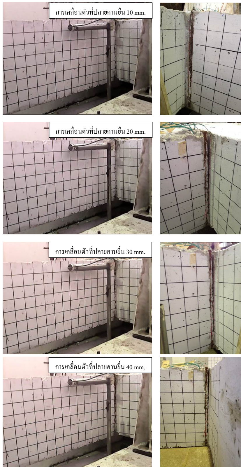
รูปที่ 2.20 ลักษณะการวิบัติของคานคอนกรีตที่มีรอยต่อแบบเพลาเหล็ก B2 16-6
