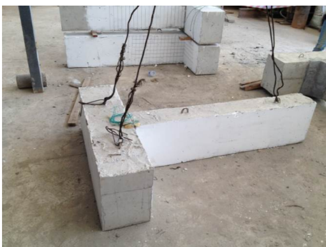
คานคอนกรีตที่ใช้รอยต่อแบบเพลทเหล็ก
