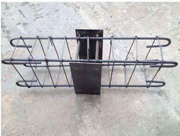
ชุดเพลทเหล็กของคานหลัก
