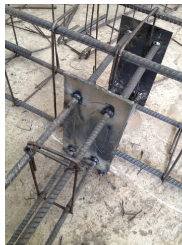
เพลทเหล็กบริเวณรอยต่อ
