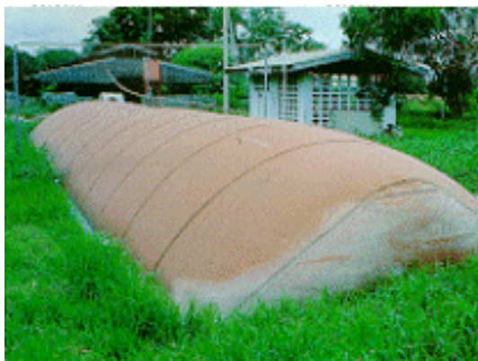
ภาพที่ 2.4 บ่อก๊าซชีวภาพแบบพลาสติกคลุมบ่อดิน ที่มา : สมชัย จันทรสว่าง, 2545
