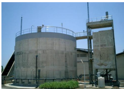
ภาพที่ 2.5 บ่อก๊าซชีวภาพแบบยูเอเอสบี
