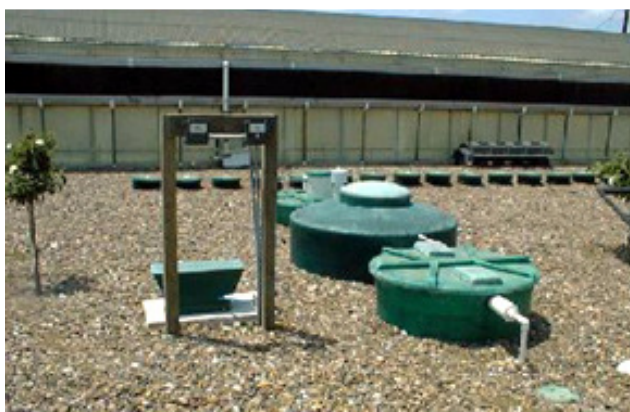
ภาพที่ 2.3 บ่อก๊าซชีวภาพแบบยอดโดม
