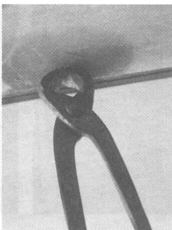
ภาพที่ 3.2.2 - 4 หากหัวตะปูไม่หลุดสามารถเห็นได้ว่าหัวตะปูจะโผล่ออกมา จากนั้นใช้คีมคีมและดึงตัวตะปูออกได้
