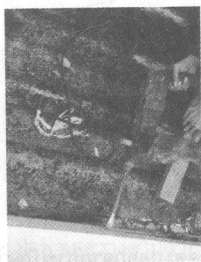
ภาพที่ 3.2.1-3 การใช้ส่วานเซาะคอนกรีตที่ยึดระหว่างโครงสร้างกับกระเบื้องมุงหลังคา
