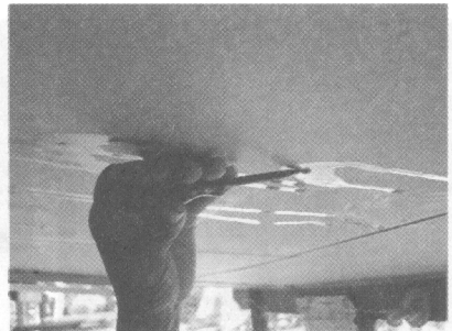
ภาพที่ 3.2.2-3 ใช้ส่วที่มีความคมจ่อหัวตะปูและและใช้ค้อนตอกเบาๆ หัวตะปูตะถูกตัด
