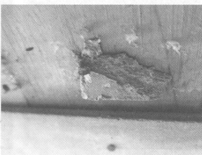
ภาพที่ 3.2.2 - 6 บริเวณที่ต้องระวังเป็นพิเศษคือ มุมฝ้าย เนื่องจากจะมีตะปูยึดหลายตัว
