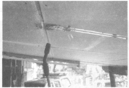
ภาพที่ 3.2.2-1 แนวกระเบื้องแผ่นเรียบและแนวตะปูที่ทำการยึดกระเบื้องแผ่นเรียบกับ
