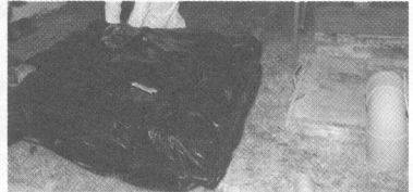
ภาพที่ 3.2.1-8 นำพาดเลวตามด้วยแผ่นพลาสติกหนาอย่างน้อย 2 แผ่น และนำกระเบื้องมุงหลังคาวาง จัดการห่อหุ้มให้เรียบร้อย
