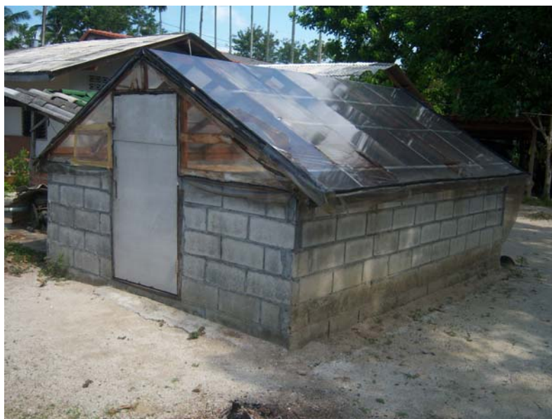
รูปที่ 3.4 เครื่องอบแห้งพลังงานแสงอาทิตย์ของวิสาหกิจชุมชนกลุ่มแม่บ้านเกษตรกรสวนจันทร์ศรี
