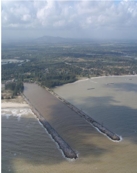
ภาพที่ 9 เขื่อนกันทรายและคลื่น (ซ้าย) และ เขื่อนกันคลื่น (ขวา)
