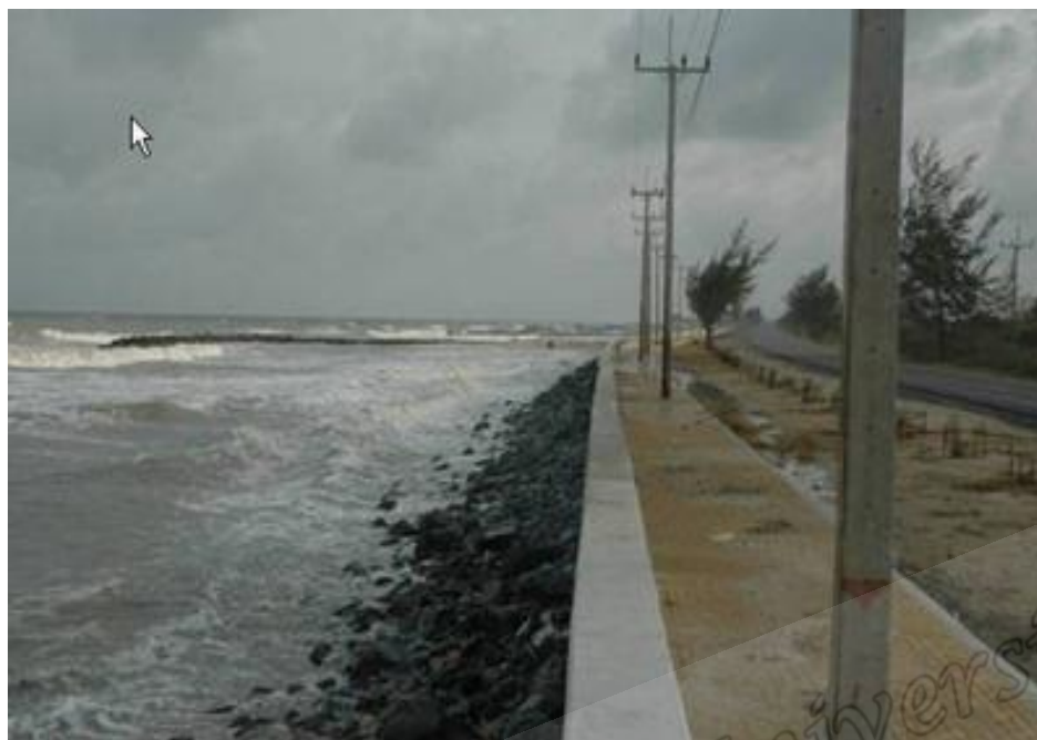
รูปที่ 6 กำแพงกันคลื่นแบบกำแพงพีคของกรมทางหลวงเพื่อป้องกันตลอดแนวถนน ตำบลขนานนาก อ.ปากฉิ่ง จ.นครศรีธรรมราช ที่มา : ปรีทศน์ (2550)
