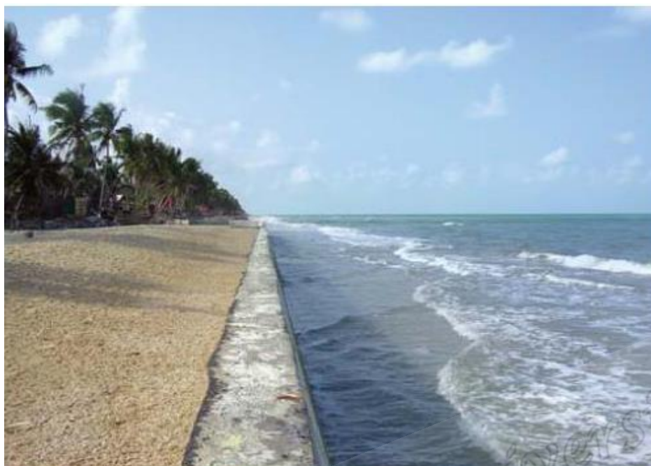
รูปที่ 8 กำแพงกันคลื่นแบบแนวตั้งบริเวณแนวชายฝั่ง บ้านหน้าศาล ต.หน้าสตน อ.หัวไทร จ.นครศรีธรรมราช ที่มา : สำนักงานนโยบาย และแผนทรัพยากรธรรมชาติและสิ่งแวดล้อม (2550)
