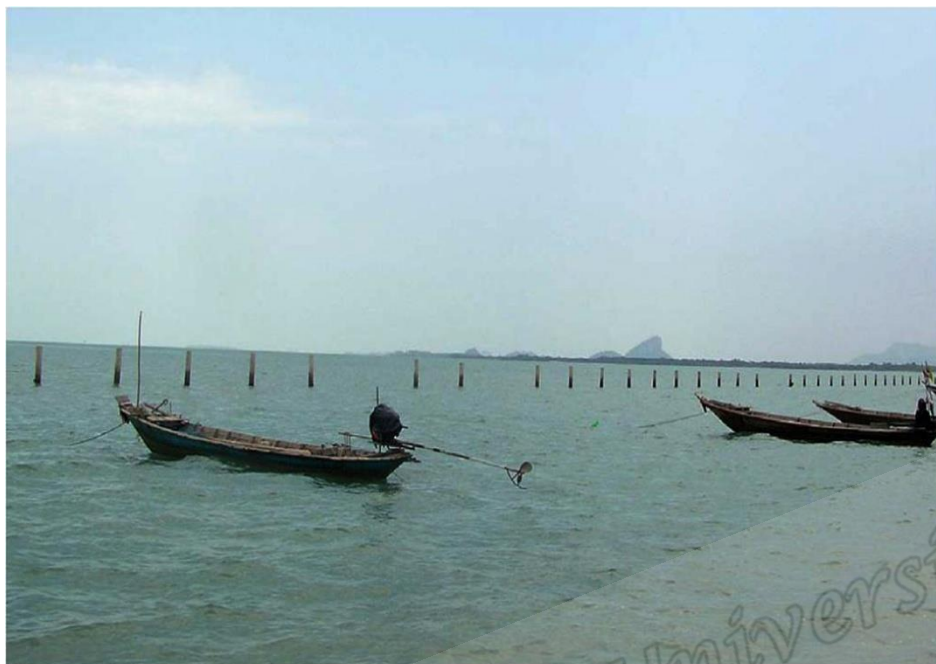
รูปที่ 2 เชือกกันคลื่นแบบเสาเข็ม บริเวณชายฝั่งบ้านพอด ต.ชลคราม อ.ดอนสัก จ.สุราษฎร์ธานี ที่มา : สำนักงานนโยบาย และแผนทรัพยากรธรรมชาติและสิ่งแวดล้อม (2550)
