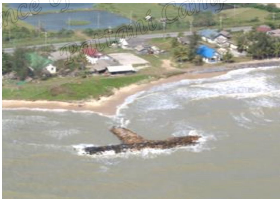
รูปที่ 5 รอดักทรายแบบตัวที บริเวณอำเภอรโนด จังหวัดสงขลา ที่มา : กรมทรัพยากรทางทะเลและชายฝั่ง (2554)
