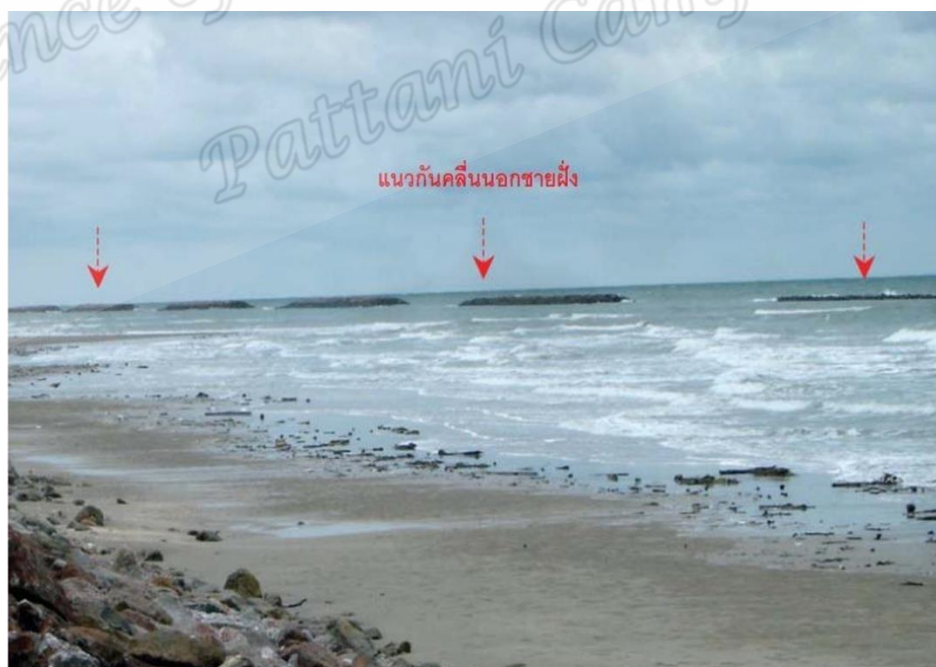
รูปที่ 7 แนวกันคลื่นนอกชายฝั่งบริเวณพระราชนิเวศมฤตทายวัน ต.นาพันสาม อ.ชะอำ จ.เพชรบุรี ที่มา : สำนักงานนโยบาย และแผนทรัพยากรธรรมชาติและสิ่งแวดล้อม (2550)
