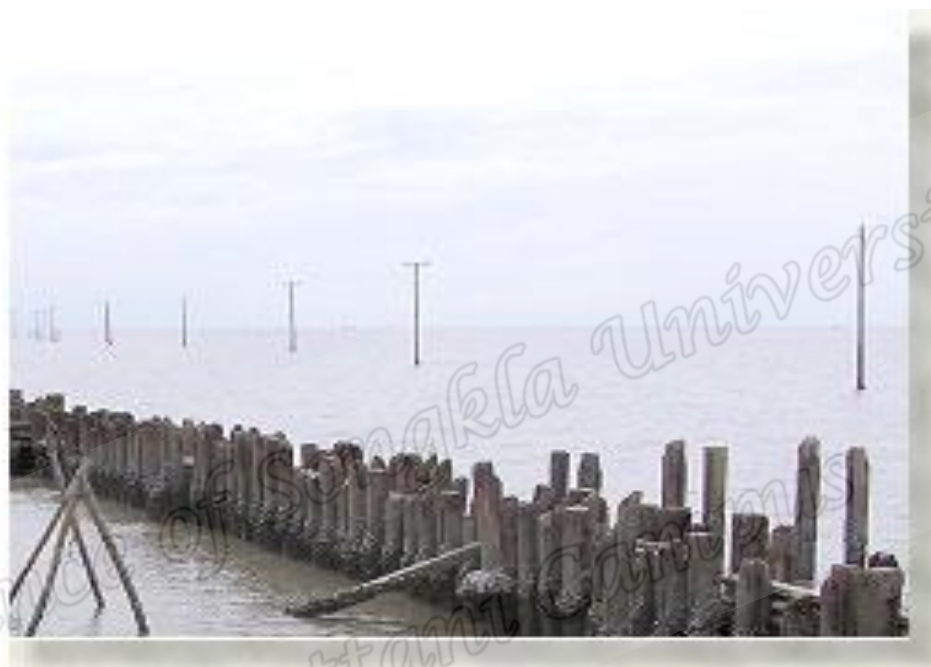
รูปที่ 1 เขื่อนกันคลื่นแบบเสาเข็มบริเวณบ้านขุนสมุทรจีน ต.แหลมฟ้าผ่า อ.พระสมุทรเจดีย์ จ.สมุทรปราการ ที่มา : สำนักงานนโยบาย และแผนทรัพยากรธรรมชาติและสิ่งแวดล้อม (2550)
