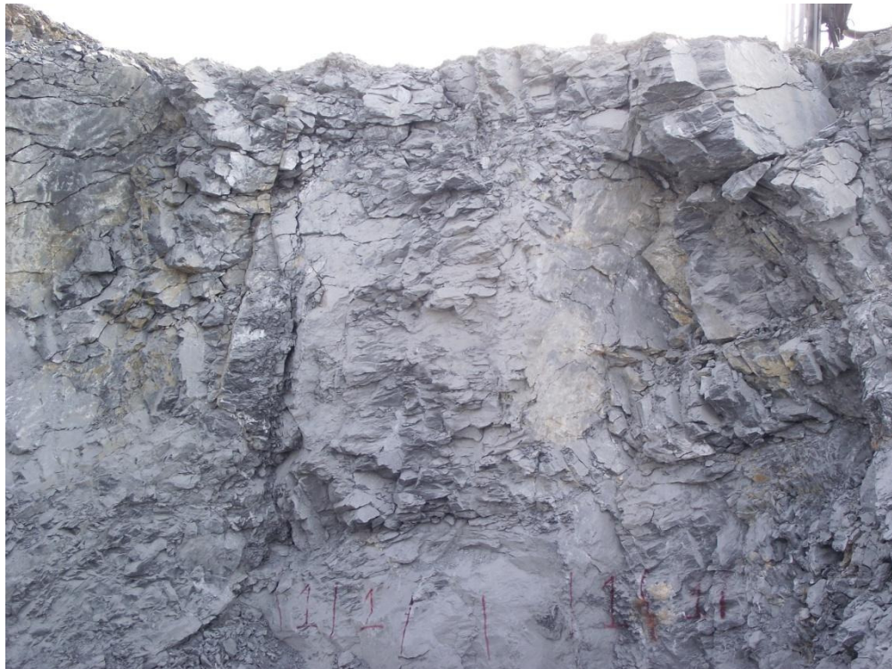
รูปที่ ข 1-7 หน้าระเบิดการระเบิดโดยใช้กรวยอุดระเบิด วันที่ 7
