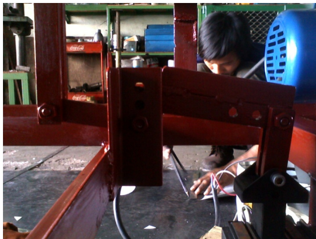
รูปที่ 4.9 การติดตั้งโซลินอยด์เบรก
