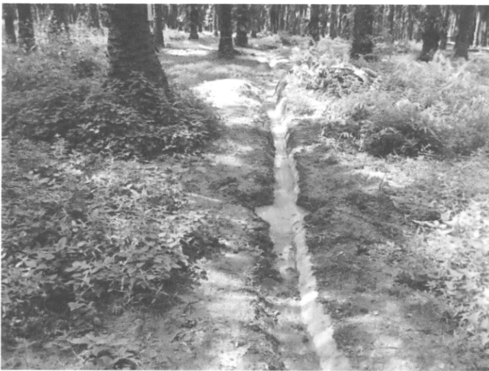
ภาพประกอบที่ 2.4 รางรับน้ำทิ้งที่ผ่านระบบบำบัดบนดิน
