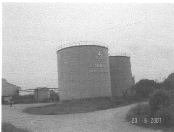
รูปที่ 2.21 ถังเก็บน้ำมัน
