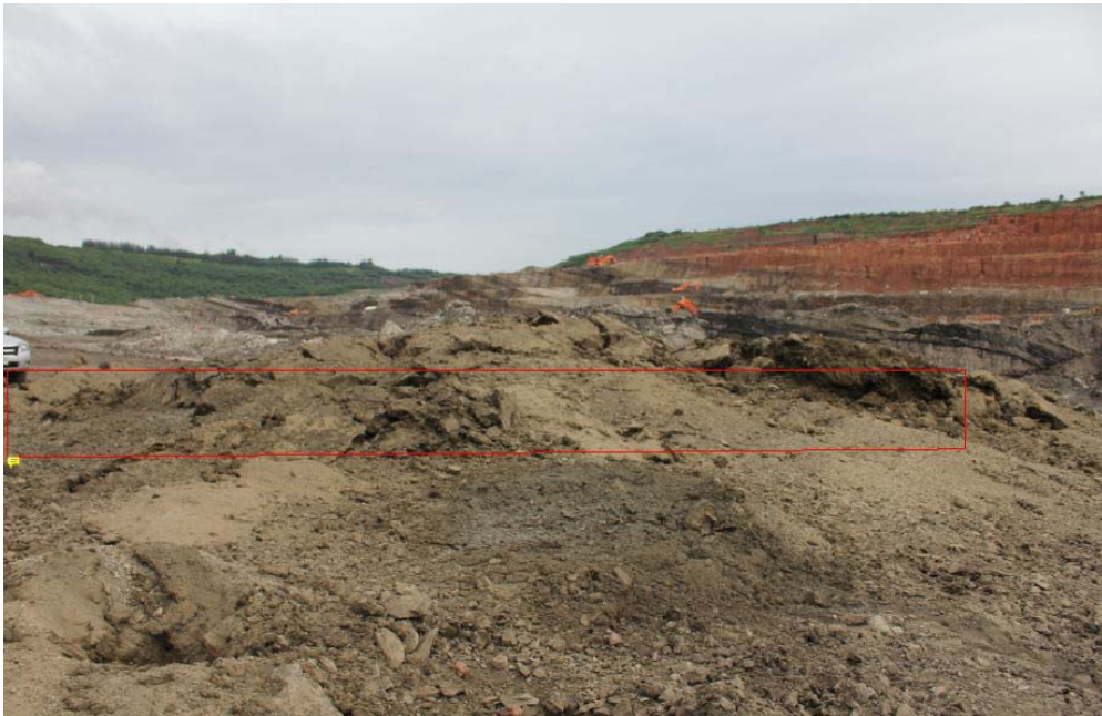
รูปที่ ผ6-12 ชุดการศึกษาที่ 11 รูปแบบของการศึกษาระเบิดเป็นแผง โดยมีการระเบิดหน้าเรียบ ถ่วงหน้า โดยเทคนิคการระเบิดเว้นช่องลมขนาดหัวเจาะ 181 มิลลิเมตรระยะห่างระหว่างรูเจาะ 21.1 เท่าของขนาดรูเจาะหรือ 3.8 เมตร ที่ความลึกรูเจาะ 10 เมตร ค่า Explosive Factor 0.19 kg/m 3
