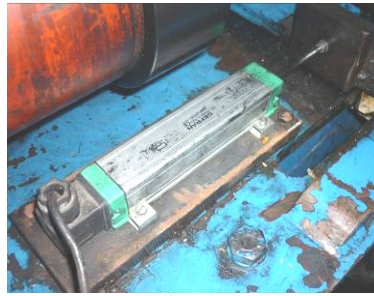
รูปที่ 3.5 การติดตั้ง Displacement Transducer
