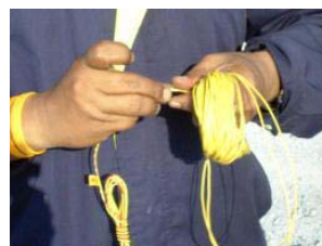
สายไฟฟ้า
