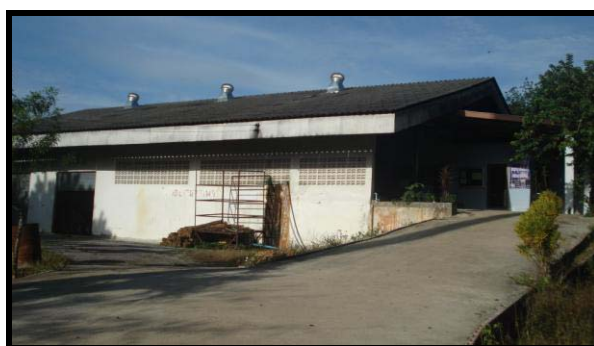
ภาพที่ 3-8 กังหันระบายอากาศ (Roof turbine)
