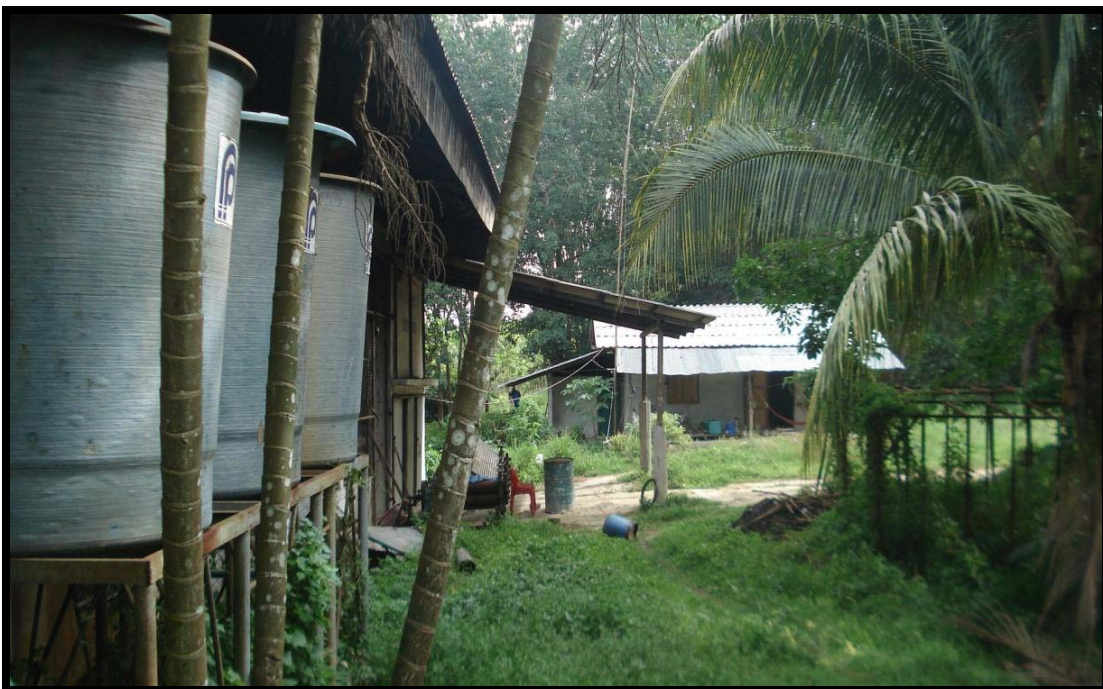
ภาพที่ 3-4 ที่พักอาศัยของพนักงานบริเวณรอบอาคารโรงงานผลิตยางแผ่น
