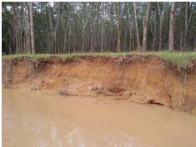
รูปที่ 1.1 แนวตลิ่งของคลองอุตะเถาที่เกิดการกัดเซาะ
