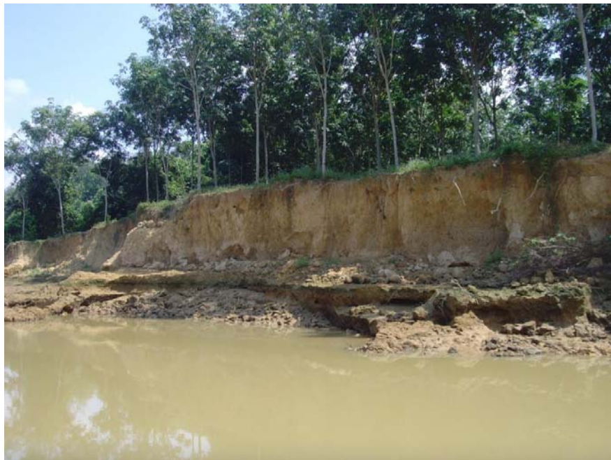
b) ตลิ่ง Section 1 หลังถูกกัดเซาะ
