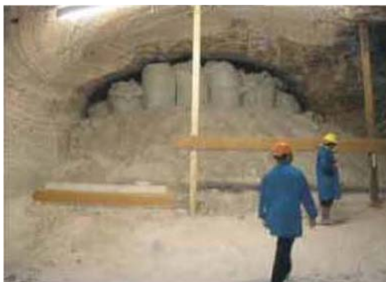
รูปที่ 1.15 การถมกลับอุโมงค์ใต้ดินด้วยวัสดุถมกลับ (กรมทรัพยากรธรณี, 2552)
