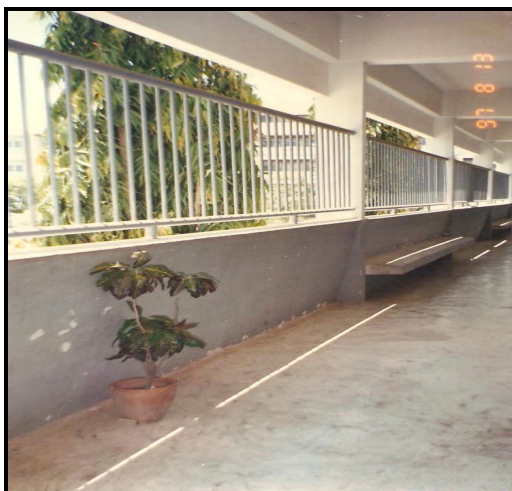
ภาพประกอบ 18 มีการติดตั้งลูกกรงเหล็กกรอบอาคาร
