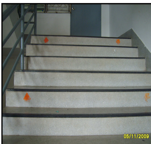
ภาพประกอบ 20 มีเครื่องหมายแสดงทิศทางการจราจรทางเท้าในการขึ้น-ลงบันได
