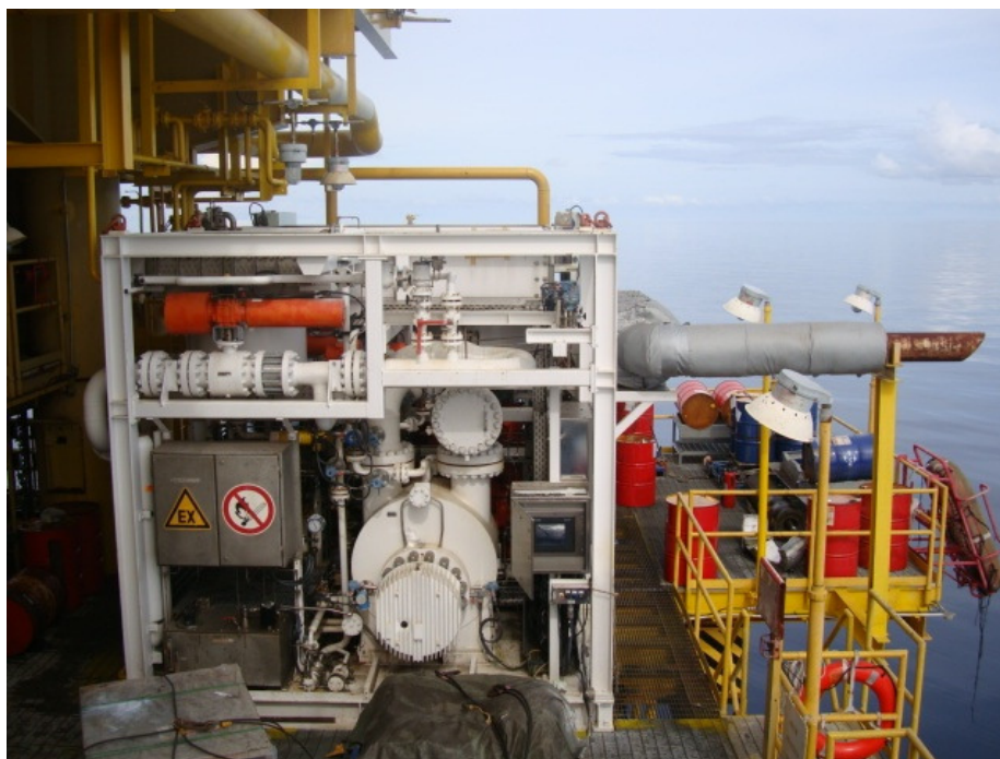
ภาพที่ 3.4 ภาพรวมของ Multiphase Pump
