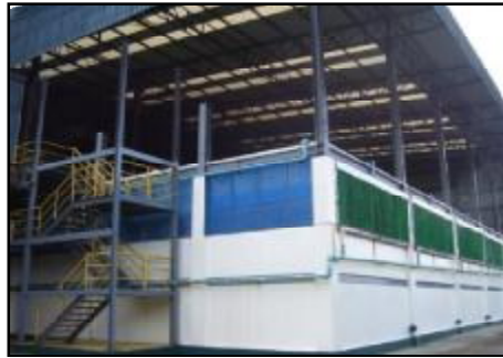
ภาพที่ 47 อาคารระบบบำบัดกลิ่น
