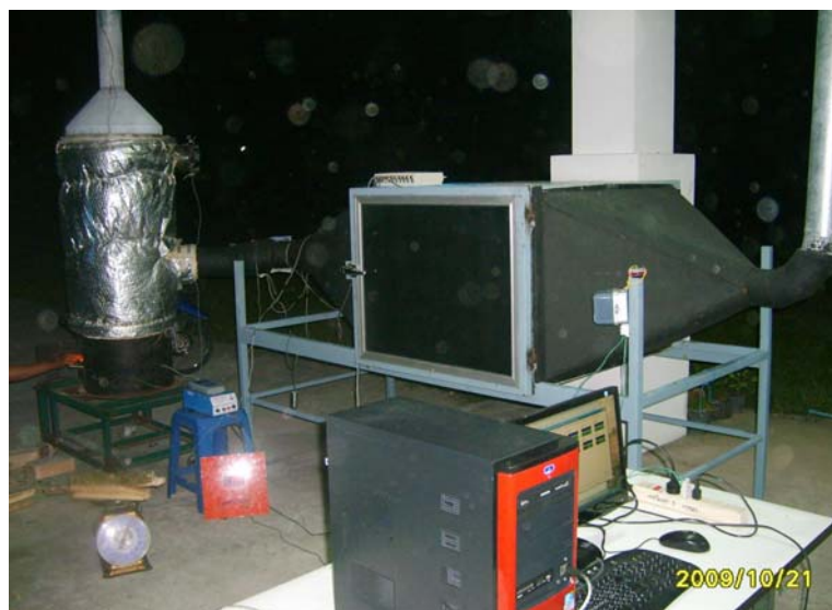
รูปที่ 4 แสดงภาพถ่ายขณะทดลองอบแห้งหมากโดยใช้พลังงานชีวมวลอย่างเดียว
