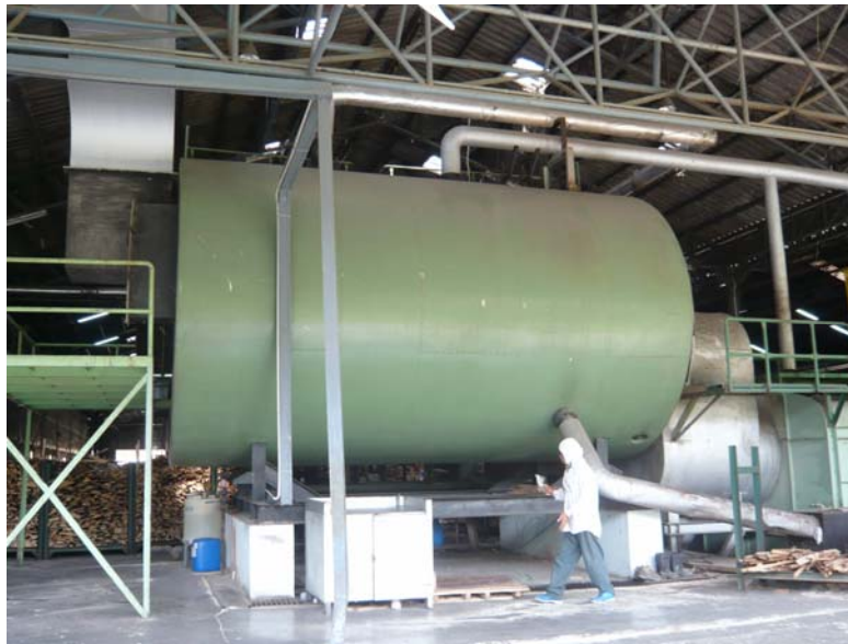
ภาพประกอบ ก.13 หม้อไอน้ำขนาด 10 ตันของบริษัท ฐิตเว็รคแอดวานซ์ จำกัด
