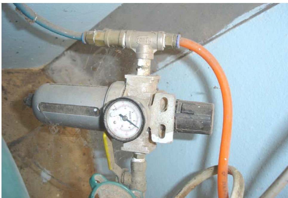
ภาพประกอบที่ ก-10 แสดงภาพอุปกรณ์ดักจับความชื้นที่ต่อเข้ากับถังลม
