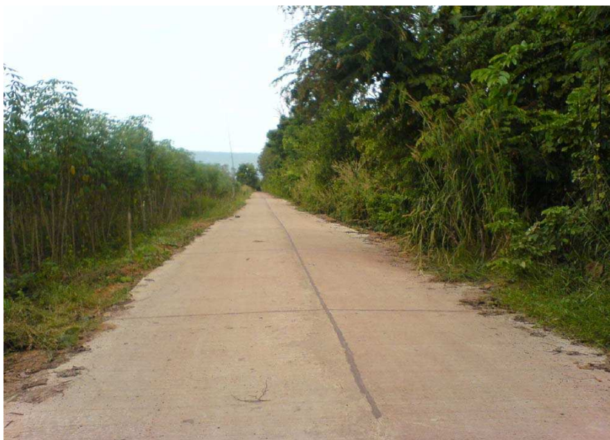
(ค) ถนนคอนกรีต
