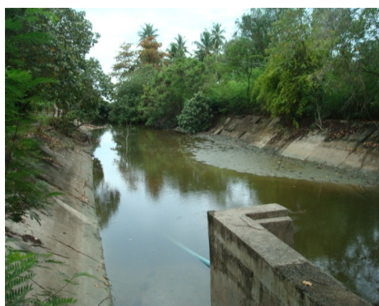
ภาพที่ 36 บ่อกักเก็บน้ำก่อนปล่อยสู่ทะเลของโรงเพาะฟักพันธุ์กุ้ง ที่มา : ถ่ายโดยผู้วิจัย (05/09/2552)
