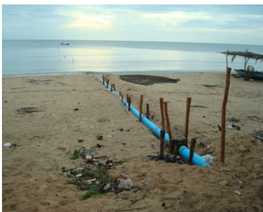
ภาพที่ 7 ท่อสูบน้ำจากทะเล เพื่อนำไปใช้ในนาทุ่ง
