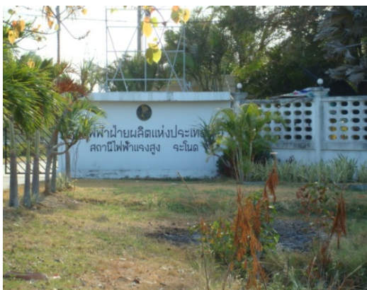
ภาพที่ 15 สถานีไฟฟ้าแรงสูง ที่มา : ถ่ายโดยผู้วิจัย (20/03/2553)
