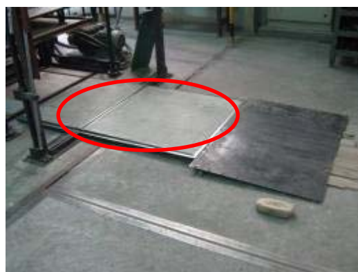
ภาพที่ ก-4 เสริมแผ่นรองล้อเลื่อน และการหล่อปูนซีเมนต์เสริมระดับ (หลังปรับปรุง)
