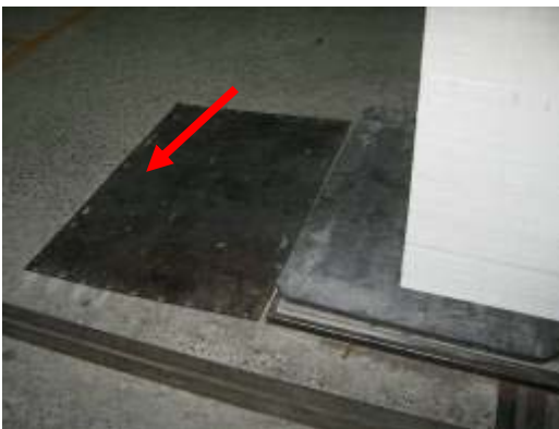
ภาพที่ ก-4 เสริมแผ่นรองล้อเลื่อน และการหล่อปูนซีเมนต์เสริมระดับ (หลังปรับปรุง)
