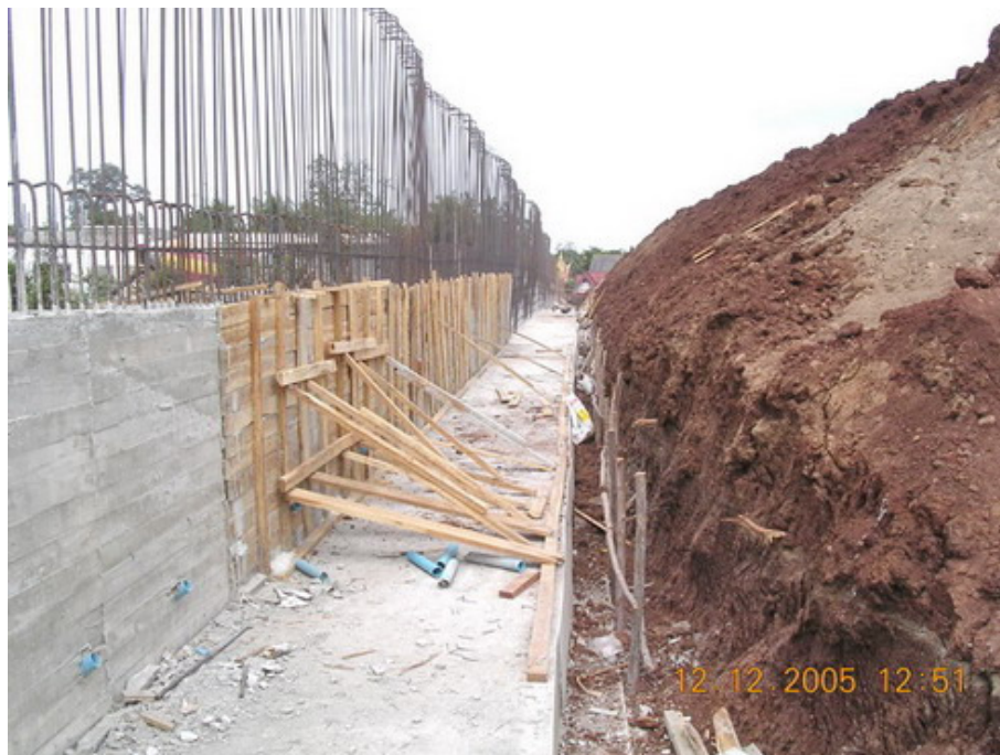
รูปที่ 1.1 การใช้ประโยชน์กำแพงกันดิน
