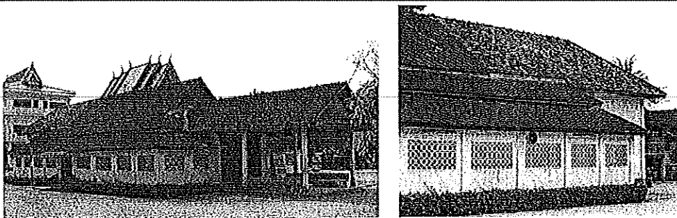
ภาพที่ 248 โรงธรรม วัดพระบาท บ้านพรุ อำเภอหาดใหญ่ รูปแบบคล้ายบ้านเรือนชาวไทยเชื้อสายจีน ภาพที่ 249 หลังคาโรงธรรม มุงด้วยกระเบื้องดินเผาเกาะยอและกระเบื้องปูนวัสดุก่อสร้างของชุมชนชาวจีนในจังหวัดสงขลา ที่มา: ผู้วิจัย
