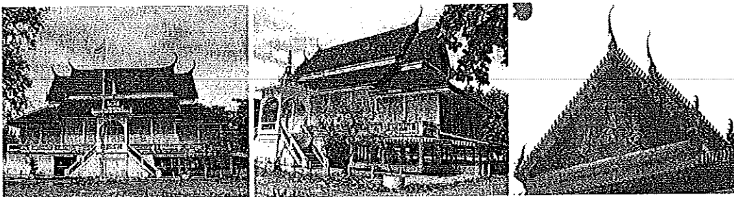
ภาพที่ 239 และ 240 อุโบสถ วัดหาดใหญ่ใน อำเภอหาดใหญ่ จังหวัดสงขลา ภาพที่ 241 การทำหน้าบันอุโบสถด้วยไม้กระดานตีซ้อนเกร็ดแนวนอน ตกแต่งด้วยลายไม้แกะสลักรูปพระอินทร์ เทคนิคการทำหน้าบันที่หาได้ยากในยุคปัจจุบัน ที่มา: ผู้วิจัย
