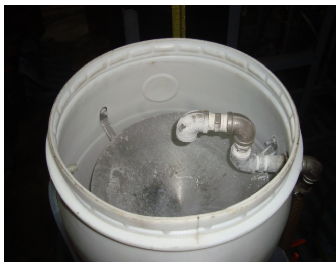
รูปที่ 3.13 ถังสารละลายของระบบผลิตไบโอดีเซลชุมชน
