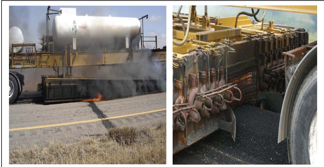
รูปที่ 2.1 การปรับปรุงโครงสร้างทางเดิมด้วยวิธีการผสมร้อน
