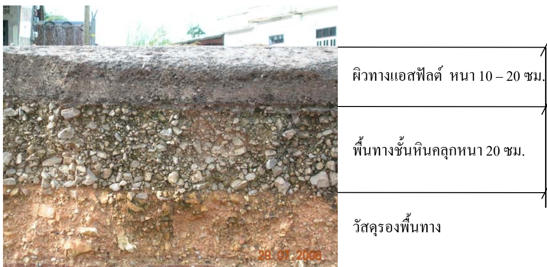
รูปที่ 3.1 ลักษณะทั่วไปของโครงสร้างชั้นทางแอสฟัลต์คอนกรีต
