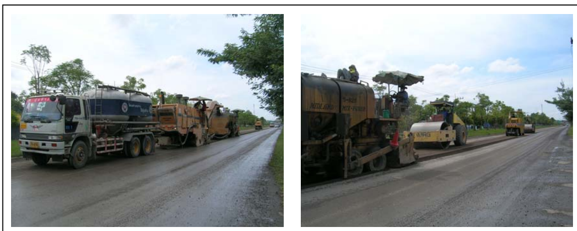
รูปที่ 2.4 การปรับปรุงโครงสร้างทางเก่าด้วยวิธีการผสมเย็น
