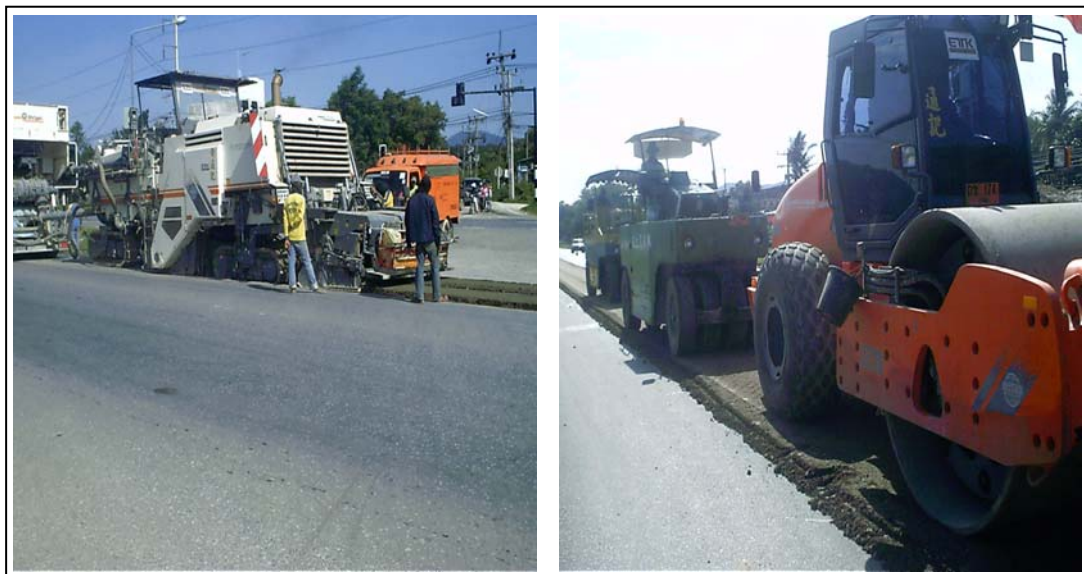
รูปที่ 2.2 การปรับปรุงโครงสร้างทางเก่าด้วยวิธีการผสมเย็น ทางหลวงหมายเลข 407 (อ.หาดใหญ่-อ.จะนะ) บริเวณ กม.24
