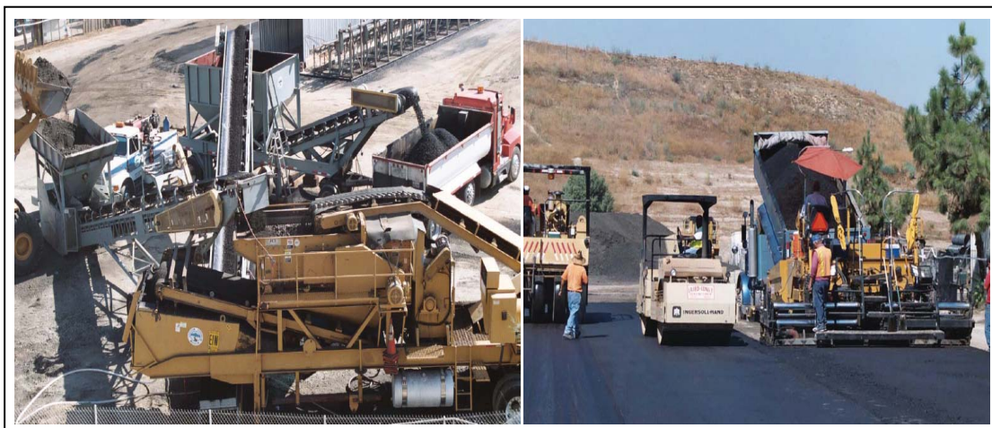
รูปที่ 2.3 การปรับปรุงโครงสร้างทางเดิมด้วยวิธีการผสมเย็นในโรงงาน
