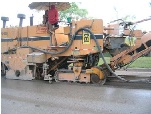
รูปที่ 3.2 การขุดลอกโครงสร้างทางแอสฟัลต์คอนกรีต
