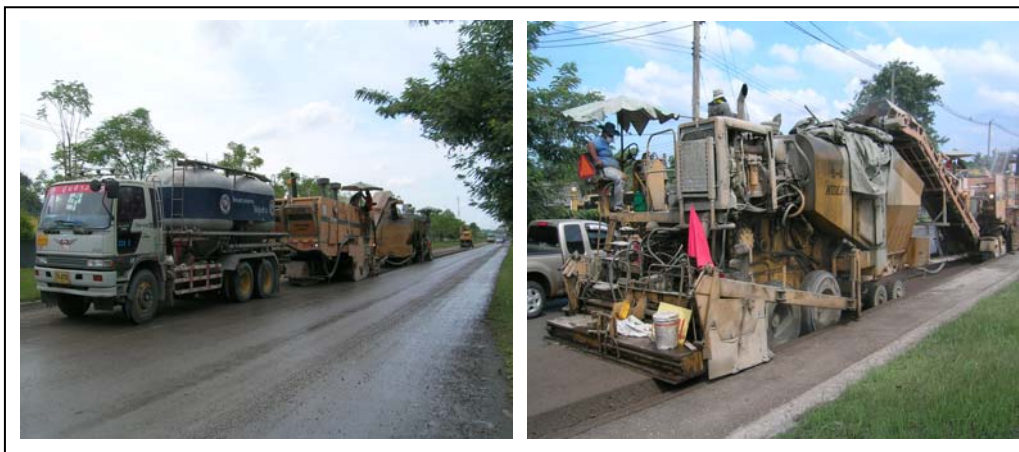
รูปที่ 2.7 กระบวนการรีไซเคิลถนนโดยใช้ซีเมนต์
