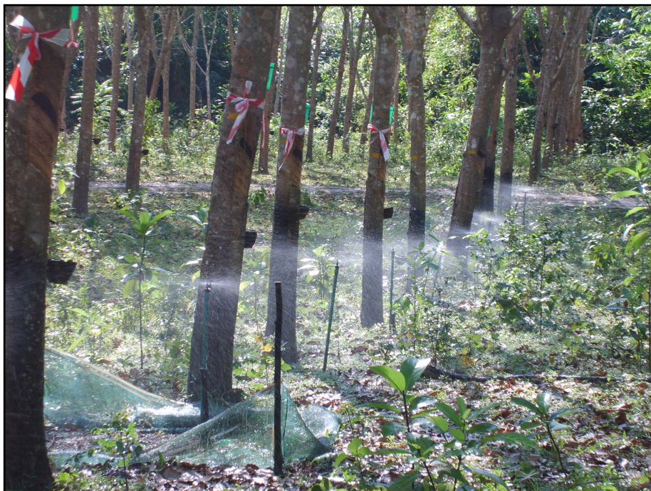
ภาคผนวกภาพที่ 5 การให้น้ำแก่ต้นยางพาราโดยระบบมินิสปริงเกอร์ รัศมี 2 เมตร ติดตั้งระหว่างต้นยางพารา ครอบคลุมรัศมีทรงพุ่ม
