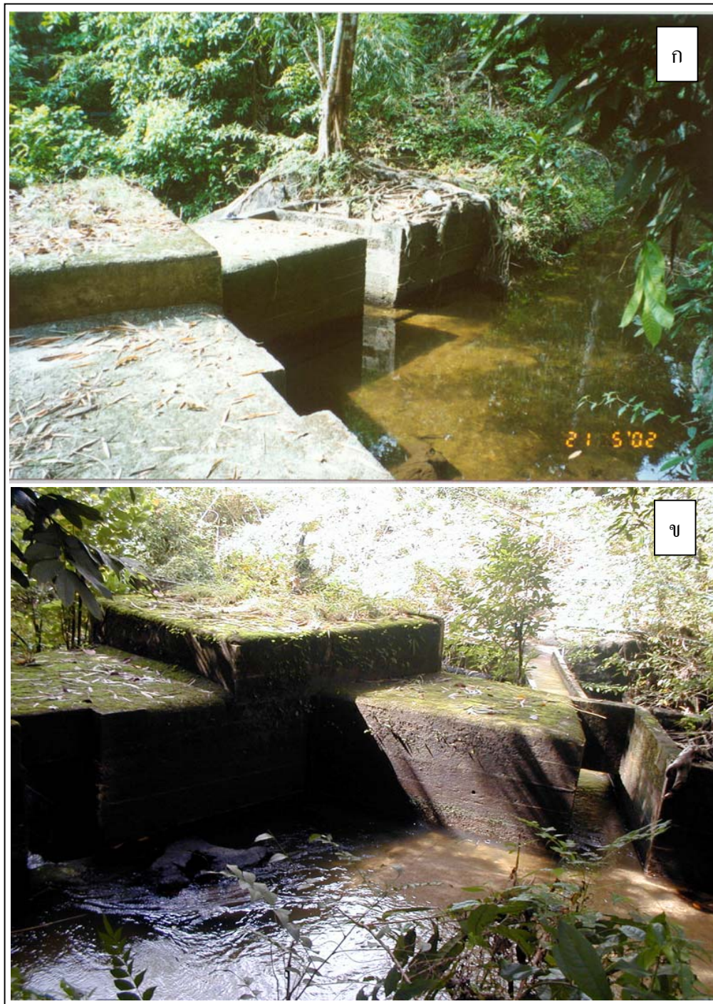
รูปภาคผนวกที่ 16 ฝ่ายกั้นน้ำคอนกรีตเสริมเหล็กรูปตัว L (ก) และตะกอนตค้างอยู่หน้าฝาย (ข) ของคู่ม่าน้ำคลองน้ำเขียง
