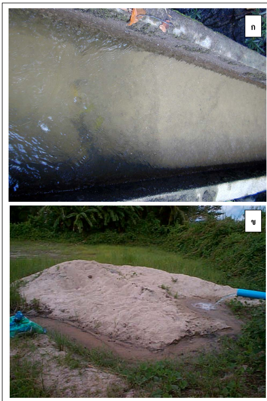
รูปภาคผนวกที่ 17 ตะกอนตกค้างอยู่ในคูคอนกรีตเสริมเหล็กส่งน้ำเพื่อการเกษตร(ก) ทราษ ที่ใหญ่มากับน้ำมาตามคูส่งน้ำ ลงสู่บ่อเลี้ยงปลาตอนล่างลุ่มน้ำ (ข) ของกลุ่ม น้ำคลองเชียง
