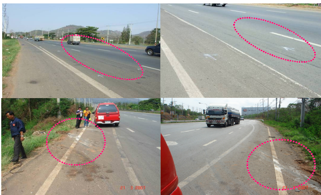
รอยล้อรถไถลบนถนนบริเวณที่รถตกถนน
