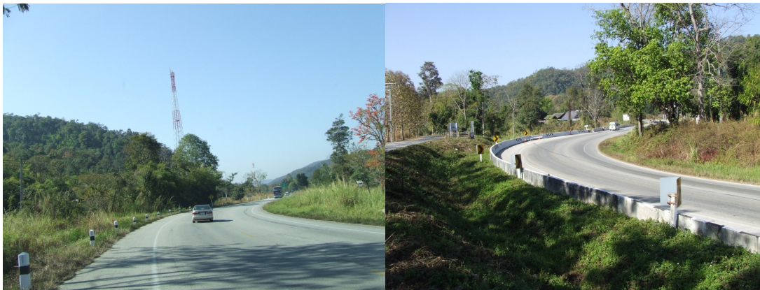
สภาพทั่วไปของถนนช่วงเกิดอุบัติเหตุ
