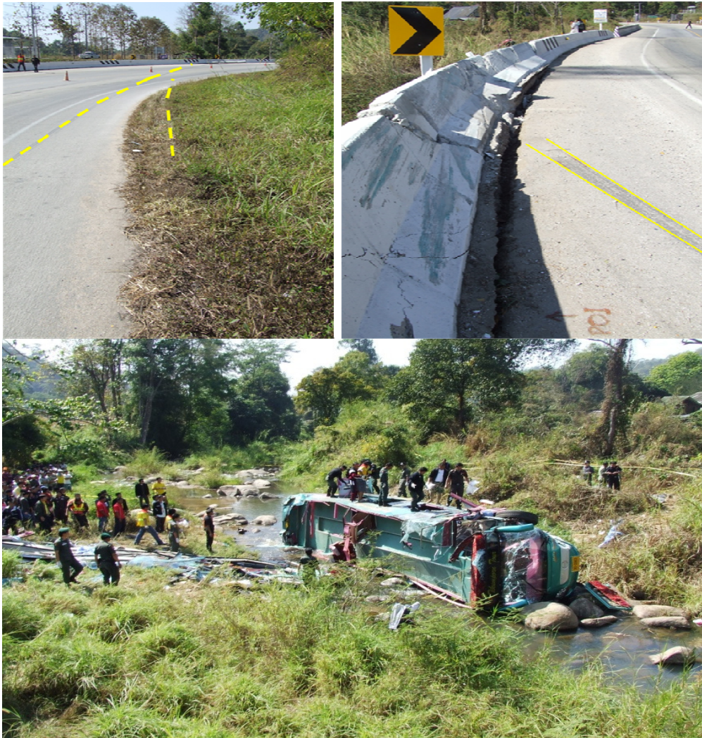
บริเวณจุดเกิดเหตุบนทางหลวงหมายเลข 118 สายเชียงใหม่ - เชียงราย หลัก กม.ที่ 42-43 บ้านปางแฟน หมู่ที่ 5 ต.ป่าเมี่ยง อ.ดอยสะเก็ด จ. เชียงใหม่
