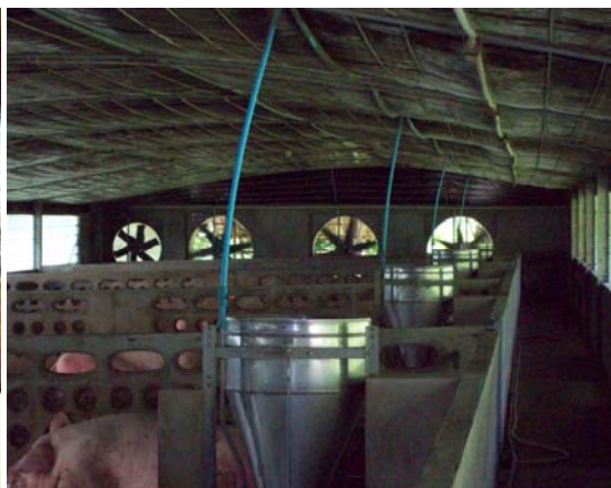
พัดลมดูดอากาศด้านท้ายโรงเรือน
