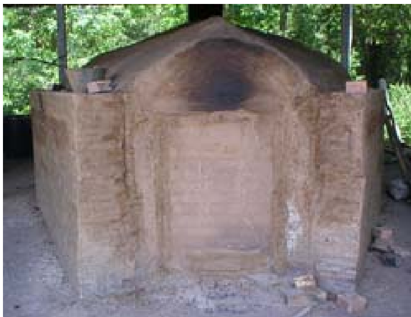
ภาพประกอบที่ 2.2 แสดงลักษณะของเตาอิวาเตะ ที่มา: http://www.charcoal.snmcenter.com
