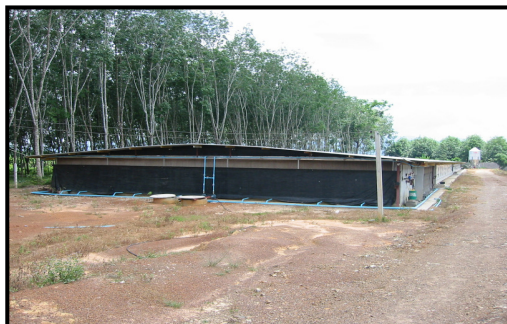
(ก) โครงสร้างภายนอกฟาร์ม (ด้านหน้า)
