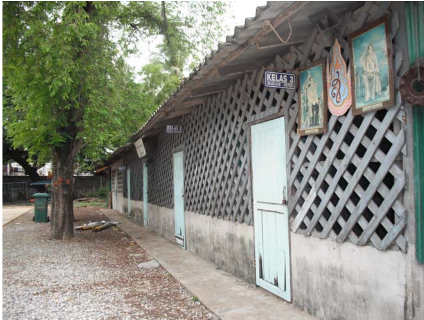
อาคารเรียนตาดึกาชุมชนยูโยปะชี อ.ปากน้ำ อ.เมือง จ.ปัตตานี
