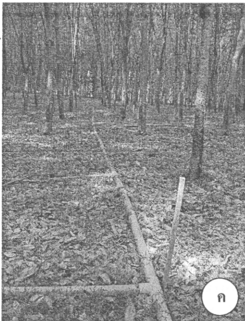
ภาพที่ 6 : การติดตั้งระบบน้ำในแปลงทดลองการให้น้ำกับต้นยางพารา
