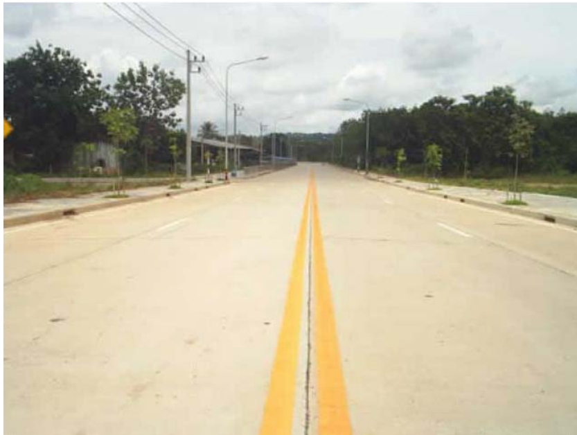
รูปที่ 3.6 สภาพโครงการแล้วเสร็จกม.ที่ 0+000 และ กม.ที่ 0+400 ที่มา : กรมทางหลวงชนบท
