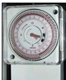
ภาพประกอบ 10 อุปกรณ์ควบคุมเวลาในการเติมน้ำเข้าระบบ การเติมอากาศ และการกรองน้ำผ่านการบำบัด
