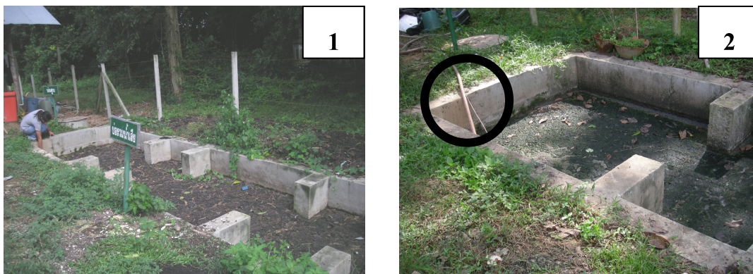
ภาพประกอบ 2-2 ลักษณะของบ่อรวมน้ำเสียของสหกรณ์โรงอบ/รมยางยูงทอง (1) และจุดที่ใช้สูบน้ำเสียเข้าระบบ MABR และ MCL (2)
