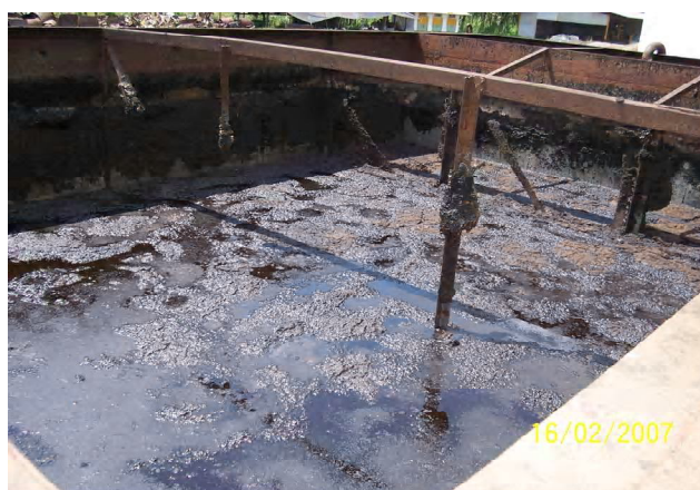
รูปภาพผนวก ข 11 น้ำเสียในบ่อปรับสภาพ ก่อนปล่อยเข้าสู่ถังหมักแบบไร้อากาศ
