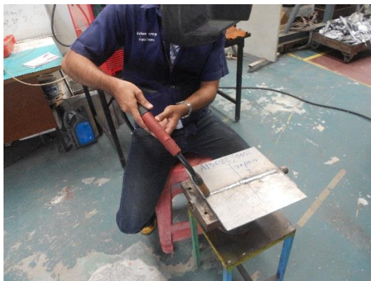
รูปที่ 3.16 แสดงการเชื่อมชิ้นงาน
