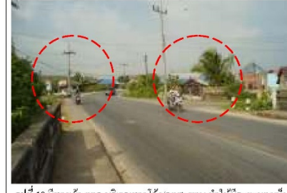
รูปที่ 10 มีทางเข้า-ออก บริเวณทางโค้ง/คอสะพาน ทำให้มีระยะมองเห็นที่ไม่เพียงพอ สำหรับผู้ที่มุ่งหน้าไปยังสวนเฉลิมพระเกียรติ 72 พรรณมา
