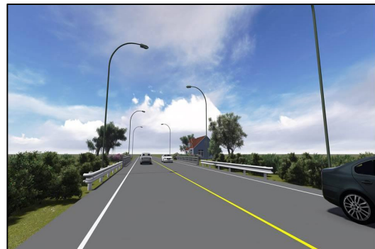
รูปที่ 4-32 ตัดแต่งต้นไม้บริเวณสะพาน ติดตั้งไฟฟ้าส่องสว่างและขีดสีตีเส้นให้ชัดเจน เพื่อเพิ่มความปลอดภัยและการมองเห็นที่ชัดเจน
