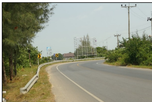
รูปที่ 4-37 มีต้นไม้บดบังบริเวณทางโค้ง ทำให้มีระยะมองเห็นที่ไม่เพียงพอ และมีป้ายโฆษณาบริเวณทางโค้ง
