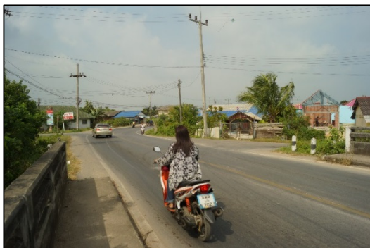
รูปที่ 4-33 มีทางเข้า-ออก บริเวณทางโค้ง/ สะพาน ทำให้มีระยะมองเห็นที่ไม่เพียงพอ
