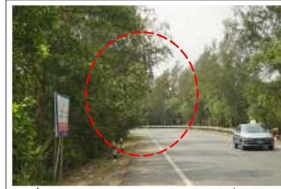
รูปที่ 9 ต้นไม้บังบั้งบริเวณทางโค้งทำให้มีระยะมองเห็นที่ไม่เพียงพอ
