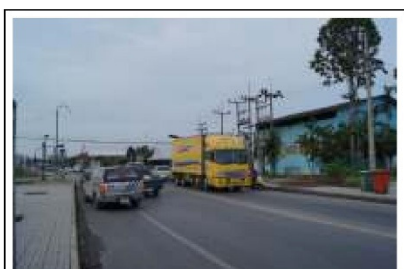
รูปที่ 16 มีทางเท้าเฉพาะบริเวณสวนเฉลิมพระเกียรติ (0+200) ส่วนช่วงอื่นๆ ไม่มีทั้งทางเท้าและทางจักรยาน
