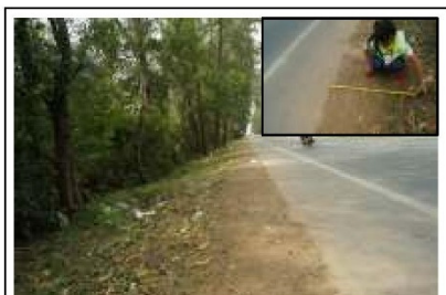
รูปที่ 17 มีผืนทรายและเลนในบางผิวจราจร อาจทำให้เกิดการลื่นไถลได้
