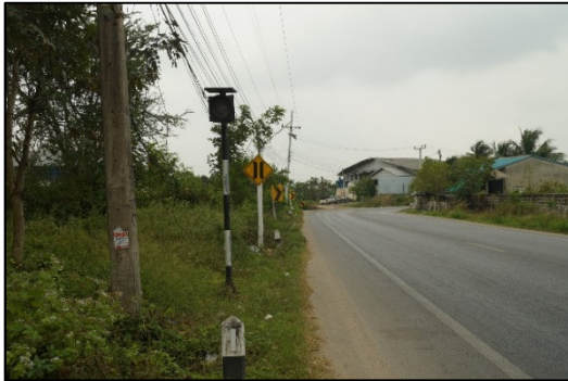
รูปที่ 4-27 สัญญาณไฟเตือนบริเวณทางโค้งเสีย และอุปกรณ์สะท้อนแสงไม่สะท้อนแสงในช่วงเวลากลางคืน
