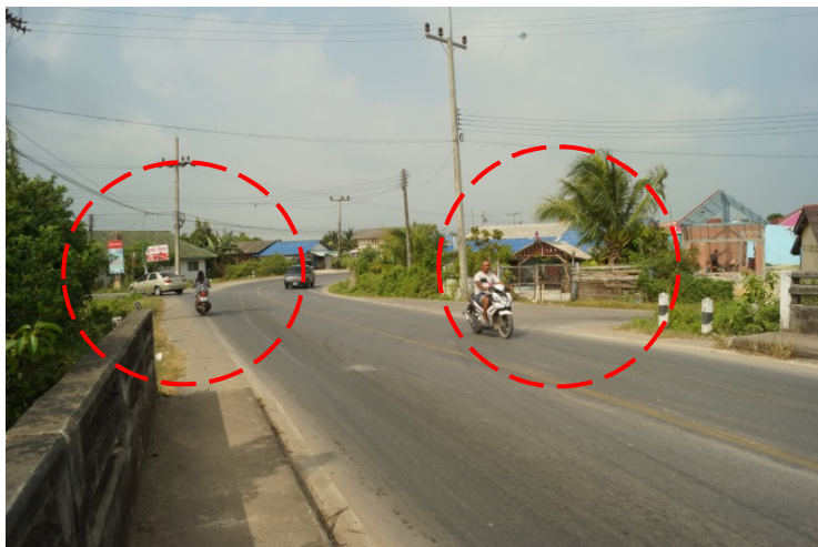
รูปที่ 4-1 ลักษณะเส้นทางที่คดเคี้ยวและมีทางเข้า-ออก บริเวณทางโค้ง/คอสะพาน กิโลเมตรที่ 2+000 ถึง 3+000
