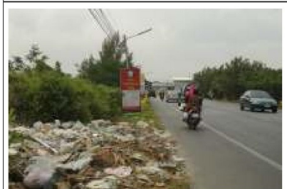
รูปที่ 19 มีขยะและป้ายโฆษณาริมข้างทางซึ่งมีทั้งอิฐ/หิน อาจทำให้เกิดอันตรายได้ และไม่สามารถหดยุครถอย่างปลอดภัย หากเกิดเหตุฉุกเฉิน
