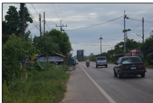
รูปที่ 4-35 มีร้านค้าบดบังป้ายทางโค้ง ทำให้ผู้ใช้รถใช้ถนนไม่ทราบถึงลักษณะเส้นทางข้างหน้า
