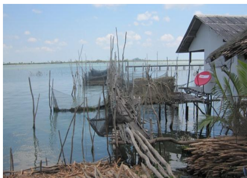
ภาพที่ 46 การนำไม้เสม็ดมาปรับปรุงซ่อมแซมบ้านเรือนที่อยู่อาศัย
