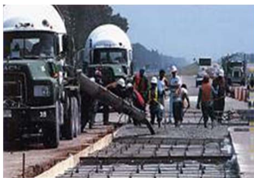
ก) ก่อสร้างผิวทาง
