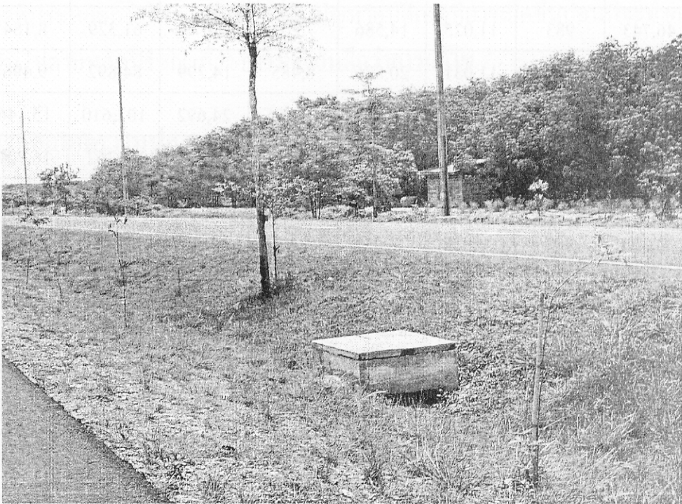
รูปที่ 1.2 : ต้นไม้และวัตถุแข็งในเขตปลอดภัยเป็นสิ่งอันตรายต่อผู้ขับขี่ ซึ่งสามารถป้องกันได้
