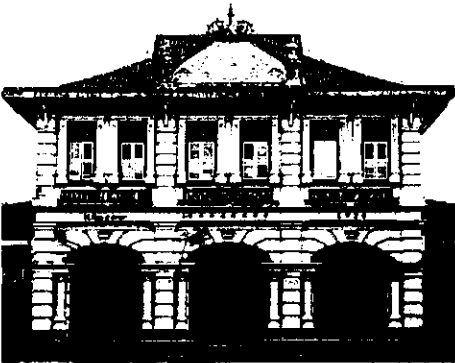
ชั้นล่างทำอย่างผนังหยาบที่เรียกว่า “Ground Floor Rustication” เป็นที่นิยมอยู่ในสมัยเรอเนสซองซ์
