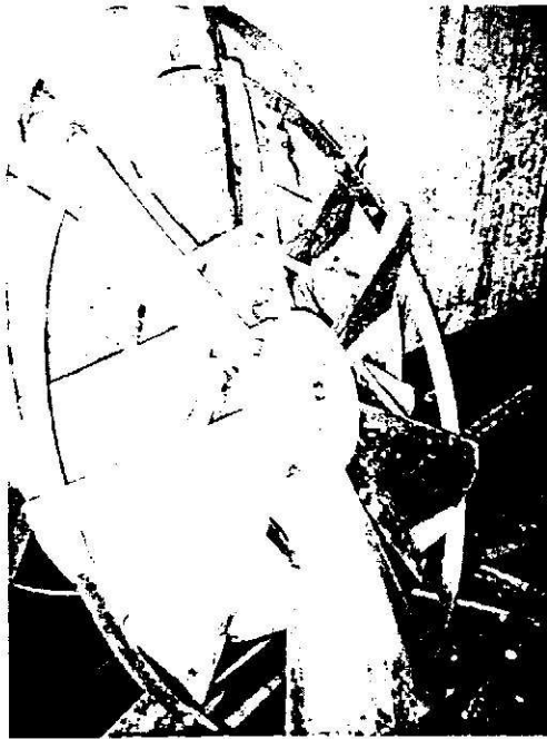
รูปที่ 17 แสดงลักษณะใบพัดลมที่ใช้ในห้องอบไม้
