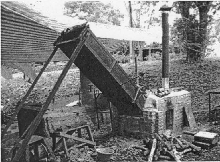
รูปที่ 5.10 ภาพถ่ายเตาเผาไหม้ที่มีชุดป้อนไม้ฟืนแบบสไลด์
