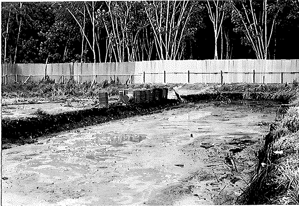
บ่อน้ำบาดน้ำเสียบ่อที่ 1
